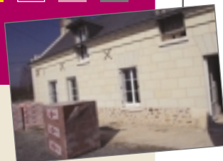
Réhabilitation en cours d'une maison à Restigné. Elle sera ensuite mise en location. Les subventions couvrent 40% des travaux.
